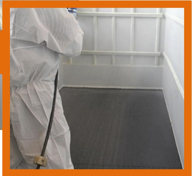
7. Auf die noch feuchte Tragschicht mittels Trichterpistole Logis Granoflour aufbringen (Absanden)
