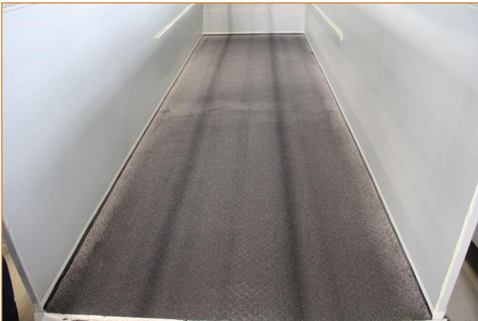
8. Von der klebfrei angetrockneten Fläche, den überschüssigen Sand abblasen oder absaugen.
