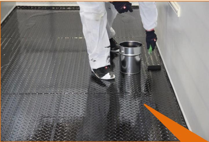
6. Die Schritte 4 und 5 für die Herstellung der Tragschicht wiederholen, aber nicht antrocknen lassen!
